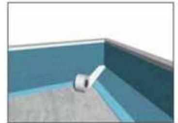
Zusätzliche Verklebung des Eckbereiches mit **Polyfleece SX<sup>®</sup> 1000**-Klebeband
