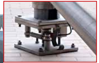
Sistema de pesaje de silos (células ATEX + indicador)
