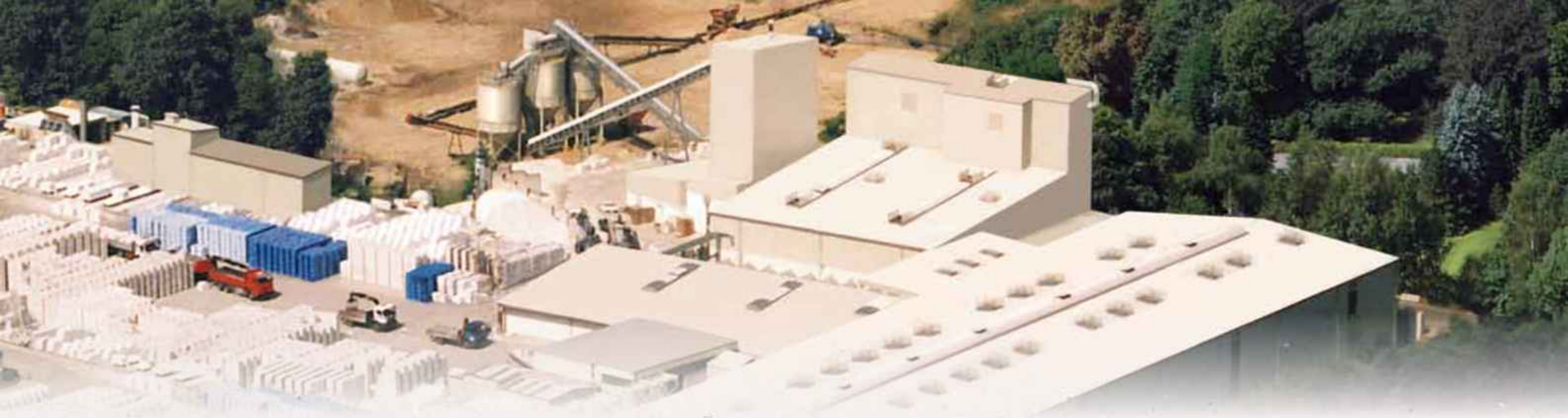
Schlüsselfertiges Kalksandsteinwerk, Kaltenkirchen
