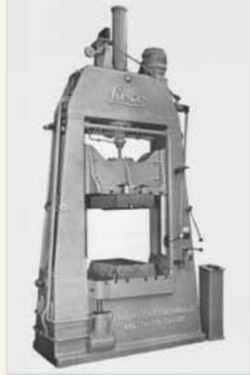
Elektro-ölydraulischer LASCO Verformungshammer VSH
