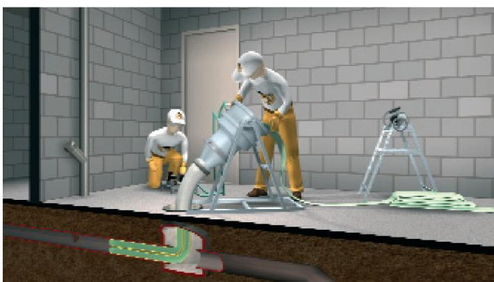
Mit einem Spezialgerät (Inversionsgerät) wird der getränkte Liner mit Druckluft in das beschädigte Rohr eingeblasen. Er wird bis zur Aushärtung der Epoxidharzmischung mit Luft oder Wasser unter Druck gehalten.
