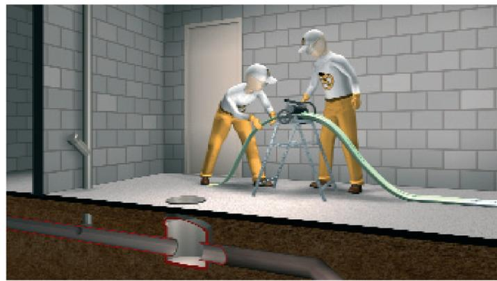
Die Epoxidharzmischung wird in den Liner eingefüllt und mittels Kalibrierwalze gleichmäßig im Liner verteilt.
