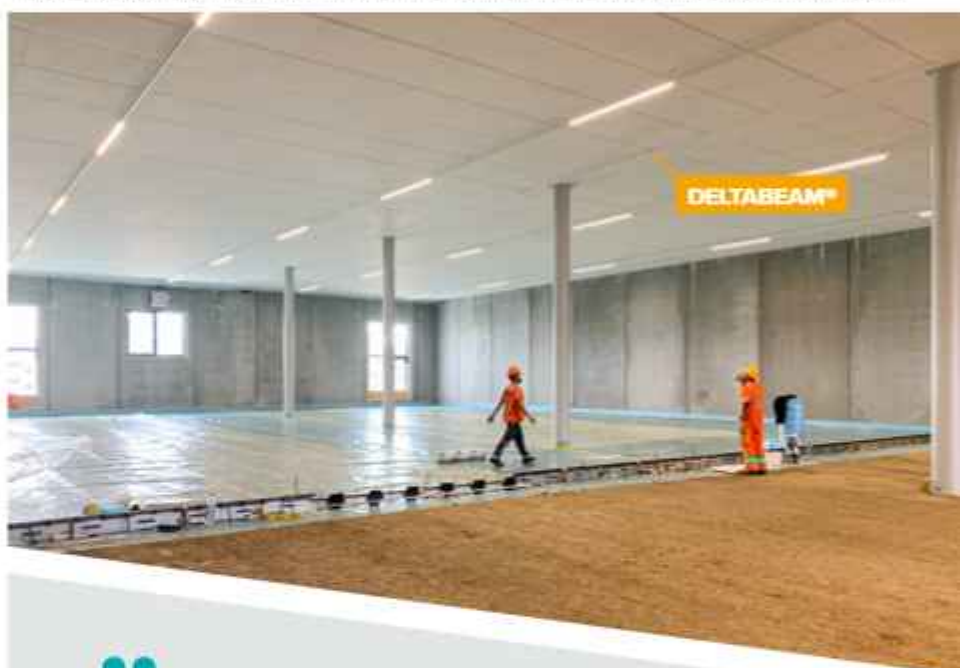
▼ Das TERAJOINT® Dehnfugensystem bietet einen dauerhaften Kantenschutz für die hochbelasteten Böden.
