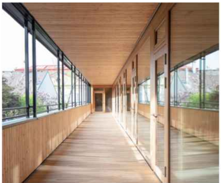
Ein lichtdurchfluteter Laubengang verbindet den Klassentrakt.
