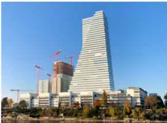
2019 Höchstes Hochhaus der Schweiz: Roche Bau 2. Hier lieferte Peikko zur Vereinfachung der Montage verschiedene Stahlbauteile für Betonfertigteile.
