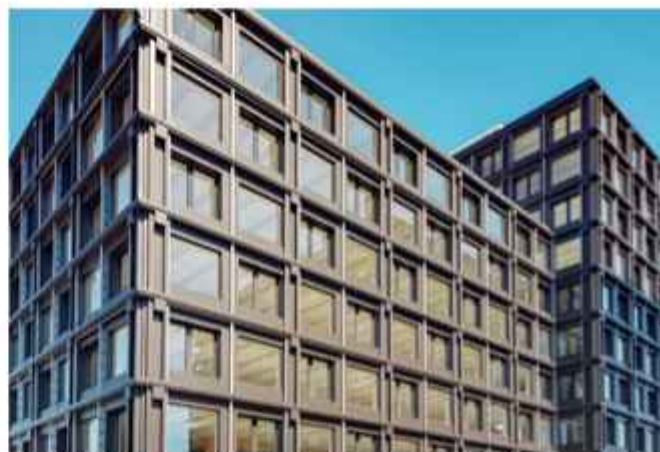
2017 Erstes Hochhaus der Schweiz in Holz-Beton-Verbundbauweise: Suurstoffli 22, Risch-Rotkreuz
