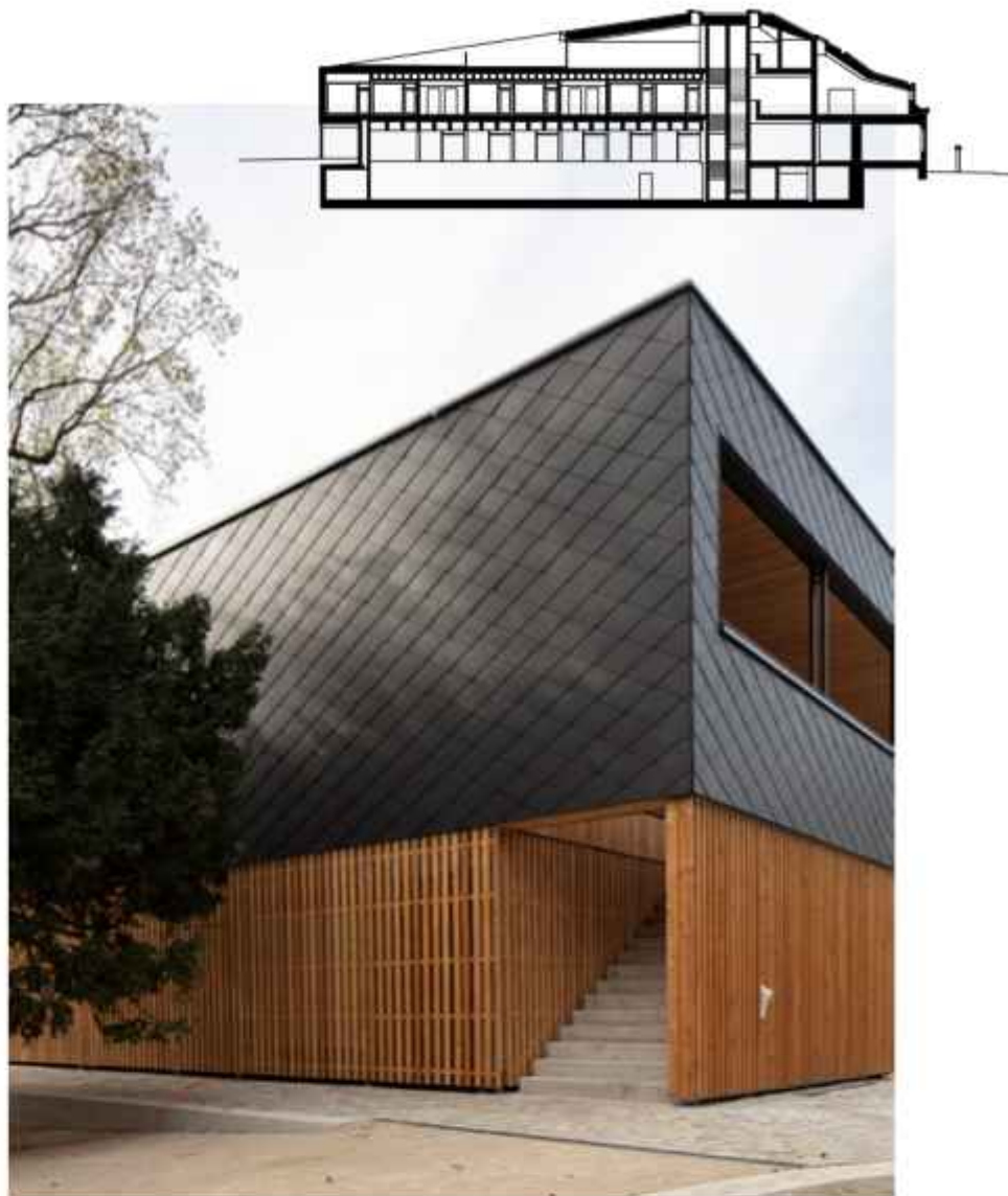
Der Pausenhof hat einen direkten Zugang zu den Klassenräumen.
