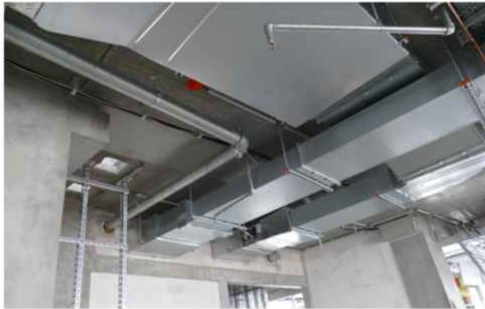
Dank der deckengleichen Unterzüge der DELTABEAM® Verbundträger können die HLK-Installationen einfach und raumsparend realisiert werden.
