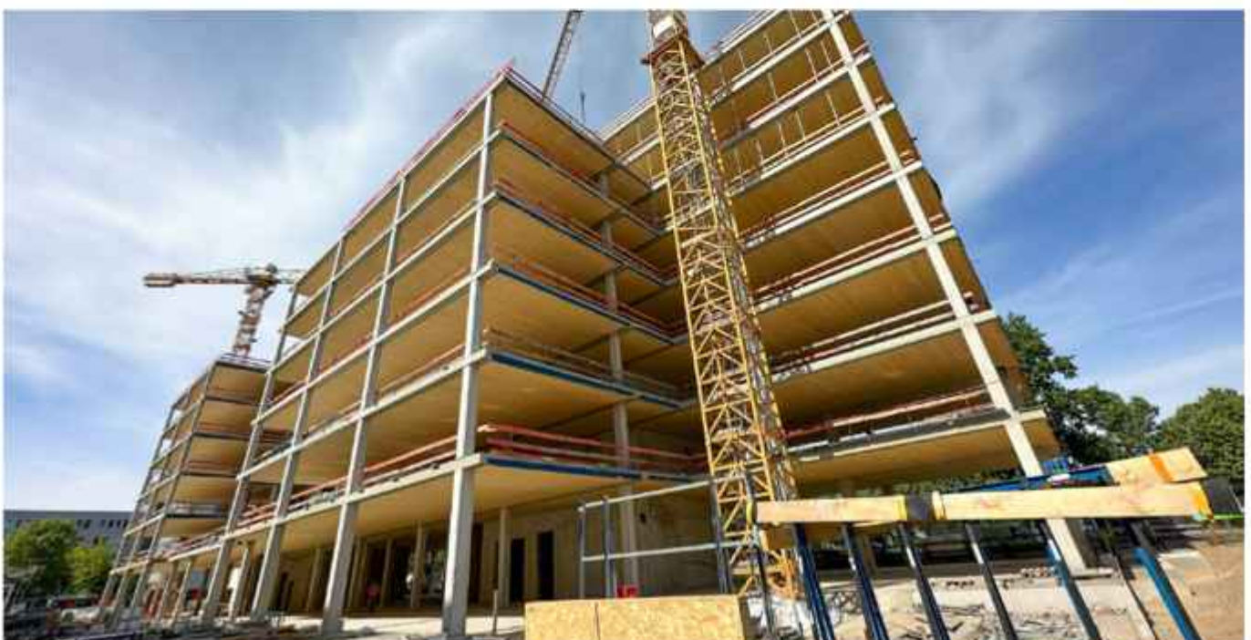
DELTA BEAM® Rand- und Mittelträger in Verbindung mit Holz-Beton Verbunddecken tragen im SPARK zur Einsparung von Energie und CO 2 bei.
