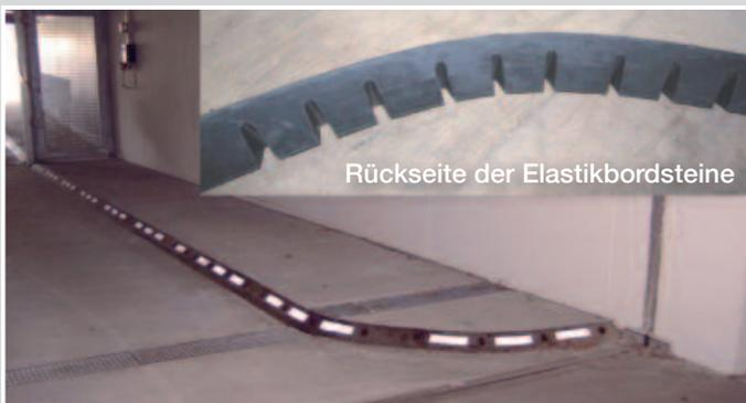
Erhöhte Aufmerksamkeit dank Elastikbordsteinen, ausgerüstet mit Retroreflexflächen, in Tunnels, Unterführungen oder in Tiefgarageneinfahrten bei Nacht und schlechten Sichtverhältnissen. Das elastische Material schützt Reifen und Fahrzeuge.
