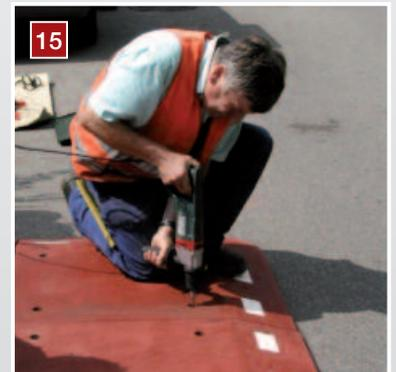
▶ Schrauben fest anziehen, bis der Schraubenkopf auf der Armierung fest aufsitzt.
