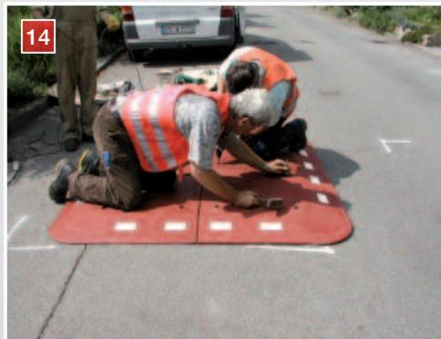
▶ Dübel bis auf die Armierung des Elementes einschlagen und die Schrauben mit U-Scheibe eindrehen.
