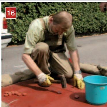
▶ Verschlussstopfen mit Wasser benetzen und mit Hammer bündig einschlagen.
