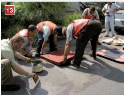
▶ Teil in den Kleber legen und Dübel mit Schrauben in die Bohrungen einführen.
