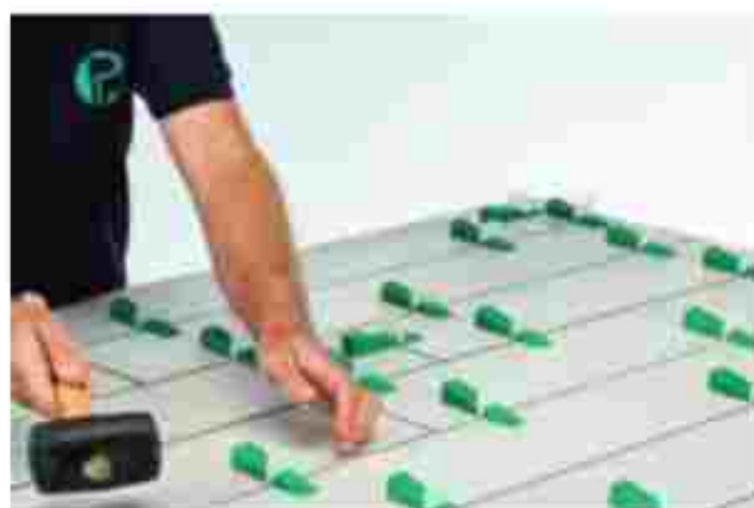
rimozione lussino e grout
