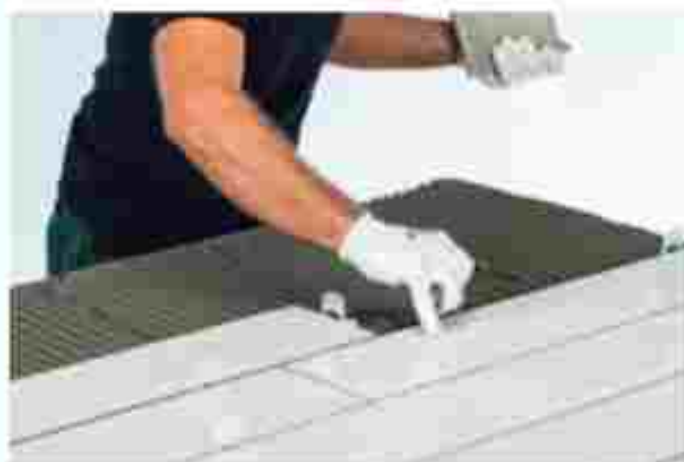
applicazione grout a petto
